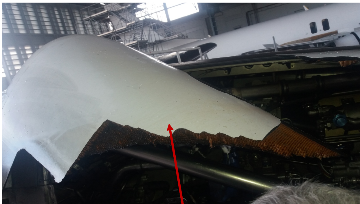
Оштећење десног бочног поклопца мотора бр. 1 Слика 2.
