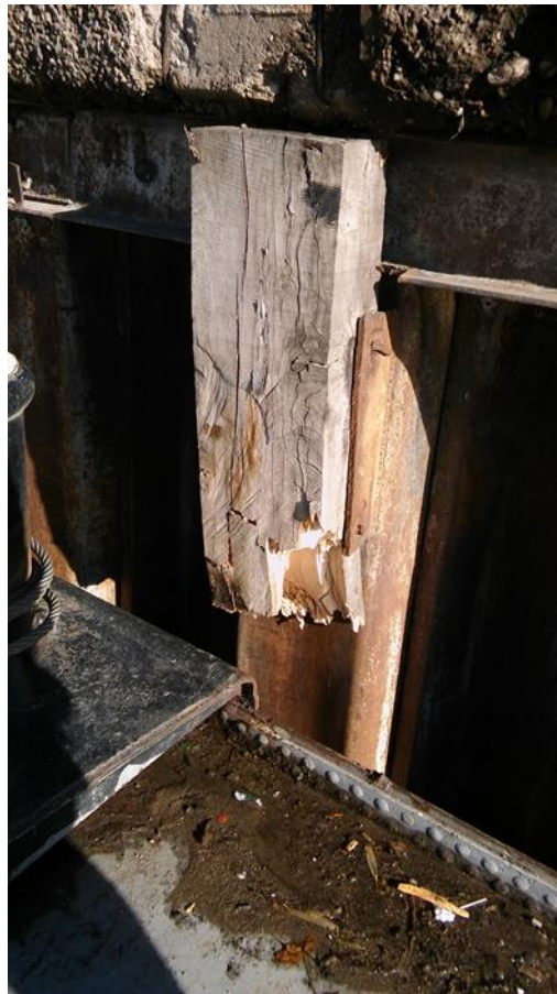
Слика 5.7.1.9. Оштећење дела дрвеног вертикалног одбојника
