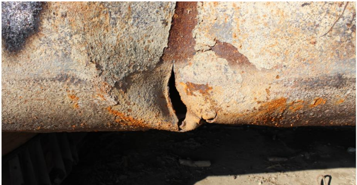
Слика 4.14. Пукотина на узвојном лиму на левом боку
