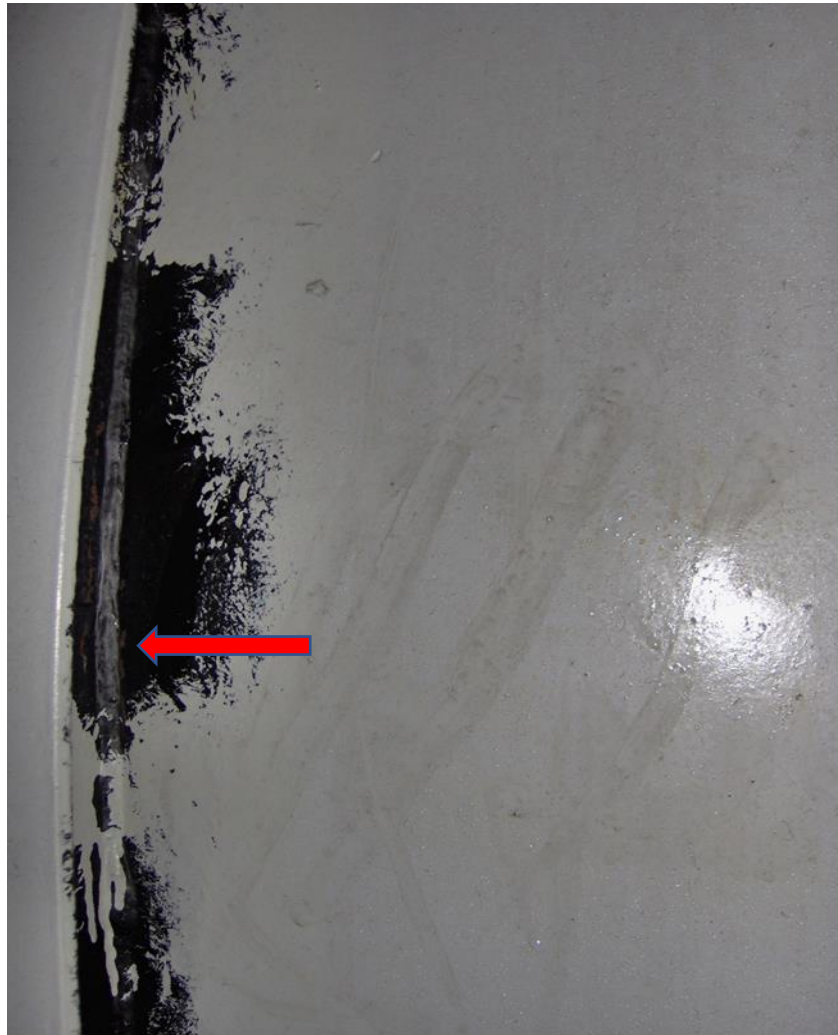
Слика 4.1.1.3. Деформација бочног ребра R175 (означена стрелицом), с/т „DELIGRAD“
