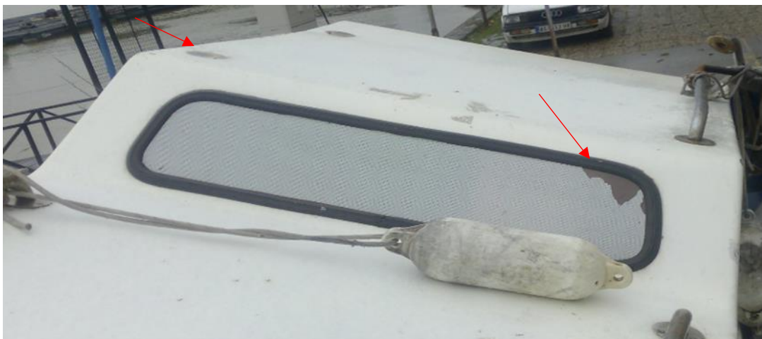
Слика 4.2.1.3. Позиција недостајућег рукохвата и оштећена залепљена фолија на стакленој површини на предњој страни чамца (означено стрелицама)
