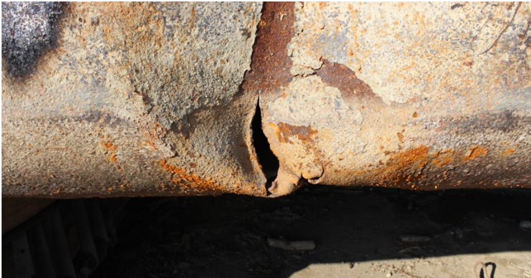
Слика 4.3.1.13. Пукотина на узвојном лиму на левом боку
