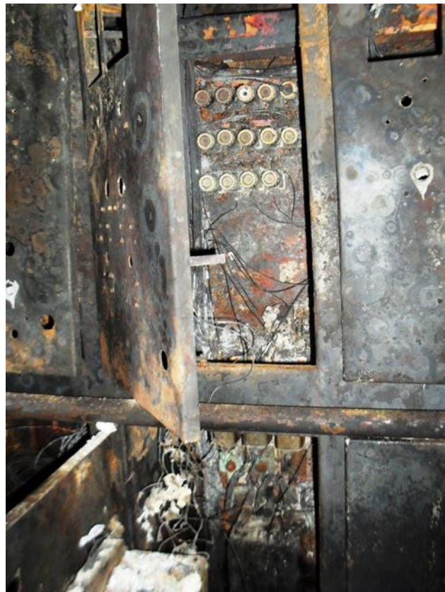
Слика 5.26. Трагови горења у трећем одељку ГРТ су нешто мањег интензитета
