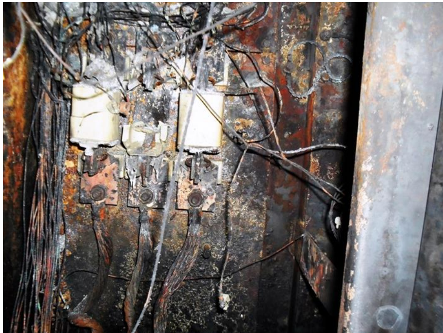
Слика 5.24. Ножасти осигурачи у ГРТ са траговима горења великог интензитета. Сви гориви елементи термички деградирани
