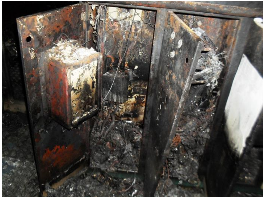
Слика 5.21. Трагови горења нарочито изражени у ГРТ у који је прикључен напојни кабл са главног ДЕА
