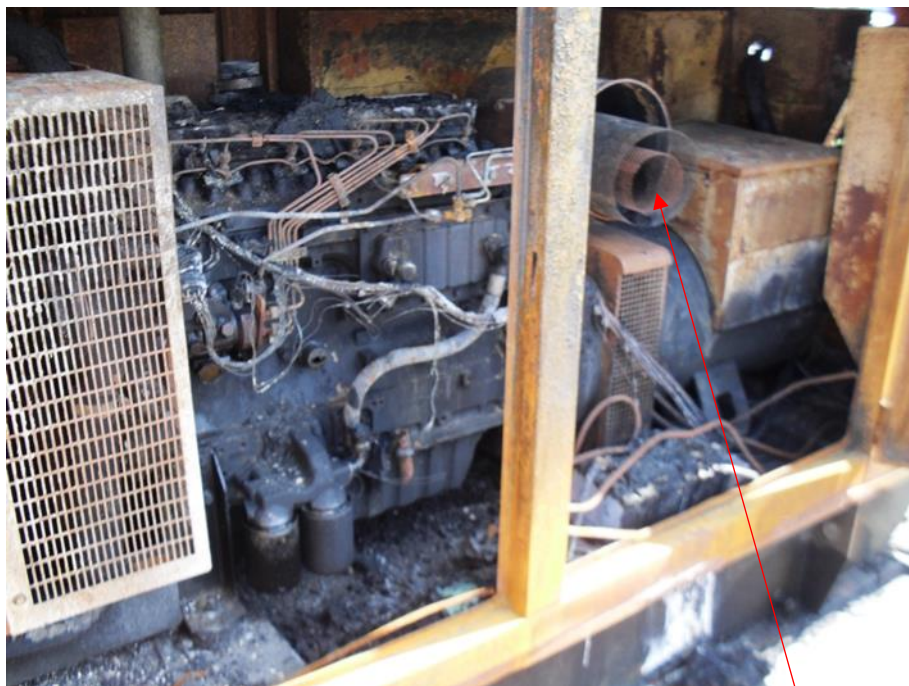
Слика 5.9. Трагови горења на мотору ДЕА изражени на спољним површинама
