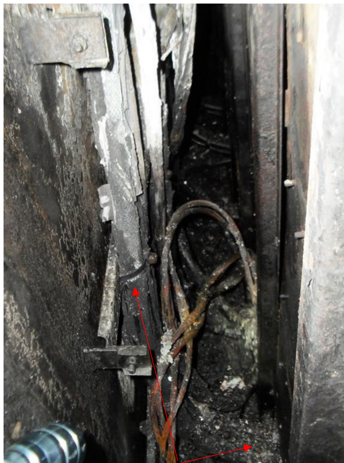
Слика 5.20. Напојни кабл којим се са главног ДЕА напаја ГРТ у машинском простору. Стрелицом обележен проводник и место улаза у ГРТ
