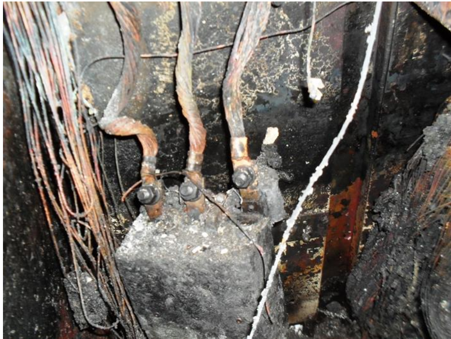
Слика 5.23. Проводници и уређаји у ГРТ са траговима горења великог интензитета
