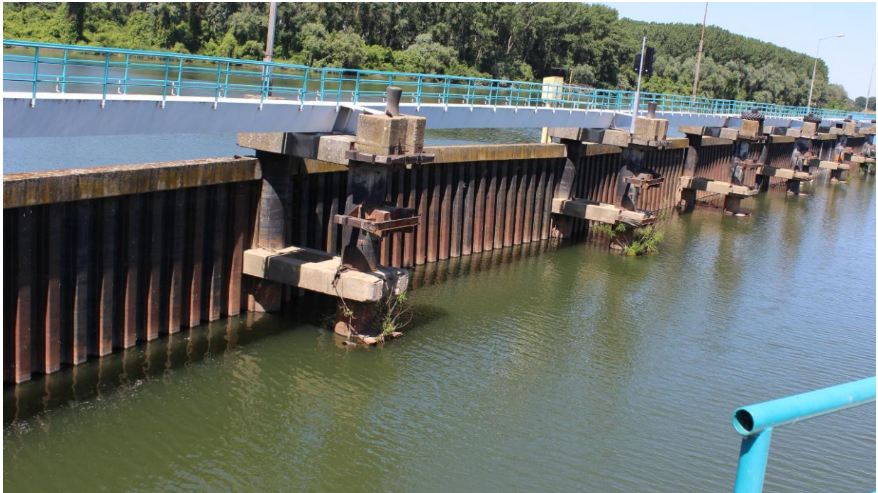
Слика 3.2.1.2. Узводна баријера предпристаништа са вертикалним стубовима за усмеравање састава у преводницу
