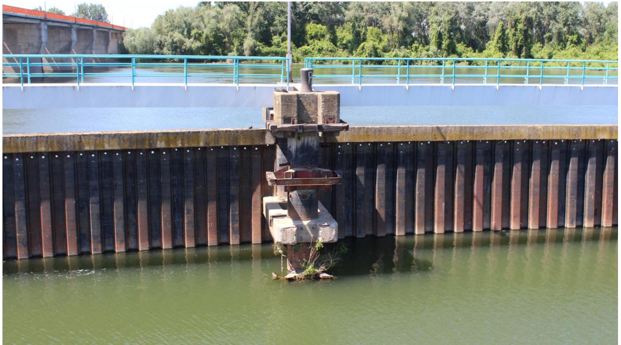
Слика 3.2.1.3. Одбојници без дрвених облога на стубу узводне преткоморе преводнице
