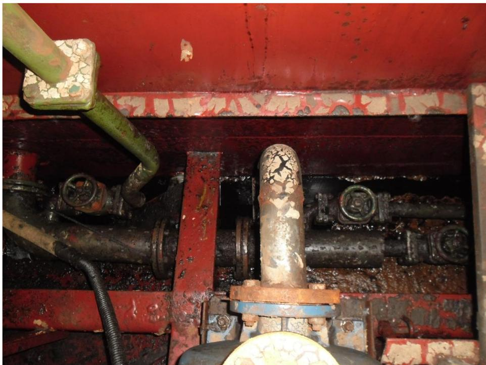
Слика 5.15. Цеви за хлађење погонских мотора спољном водом
