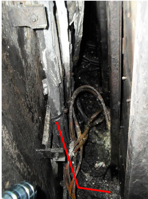
Слика 4.1.1.5. Напојни кабл којим се са главног ДЕА напаја ГРТ у машинском простору. Стрелицом обележен проводник и место улаза у ГРТ
