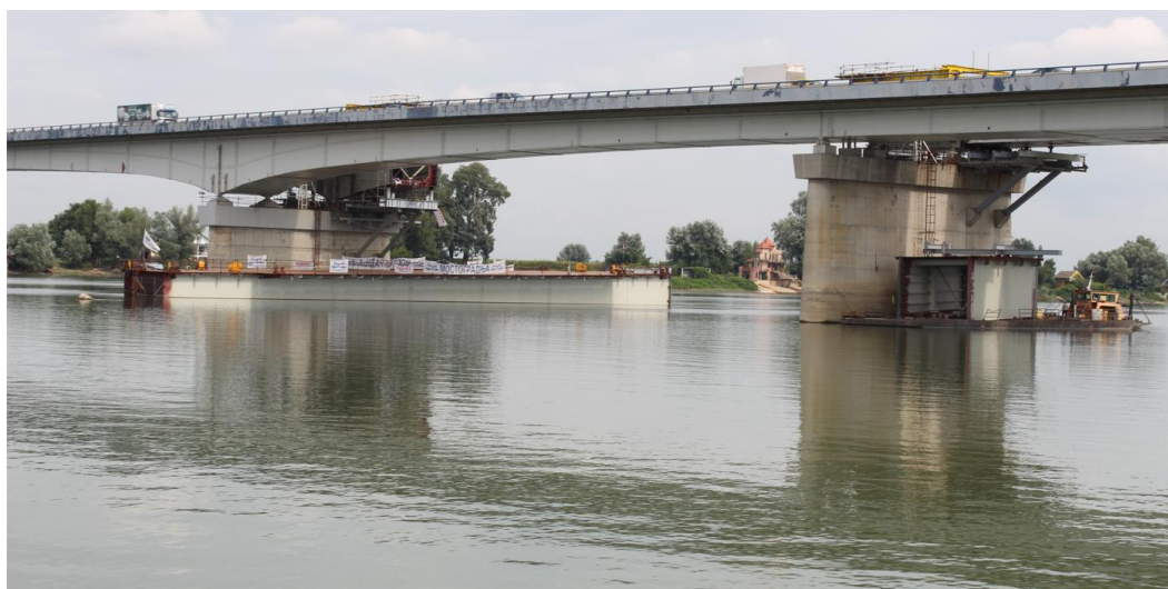
Слика 4.2.1.2. Пловећи сегмент конструкције моста
