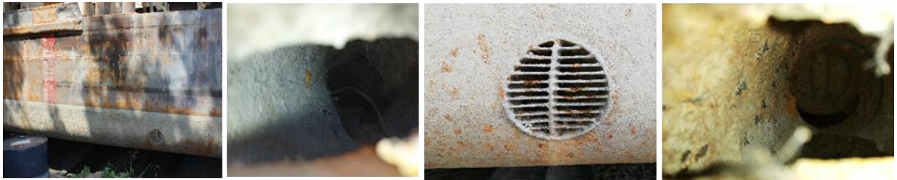
Слика 4.4.1.6. Усисни оплатни отвори десне и леве доводне цеви у резервоар
