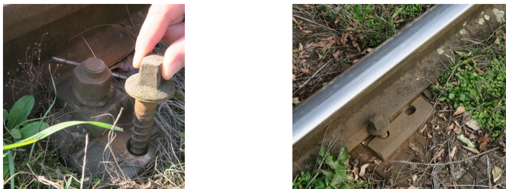
Слика 4.2.5.3: Веза шина праг причврсном плочом и директно причвршћење тирфонима
