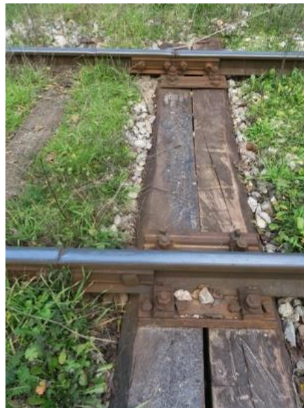
Слика 4.2.5.2: Последица путовања шина
