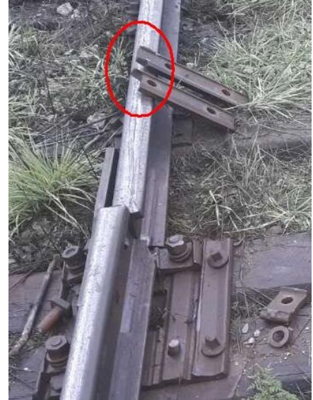
Слика 4.1.2: Траг удара и пењања точка на помереном саставу леве шине и пукнута везица (извор: „ИЖС“ а.д.)
