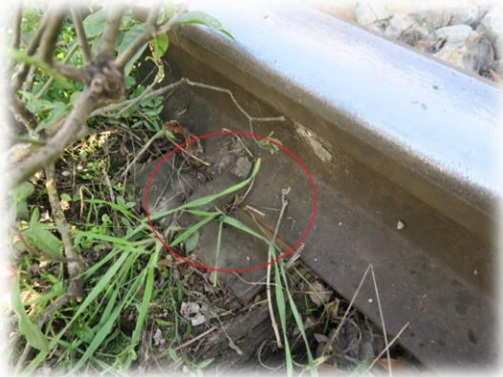
Слика 4.2.3.3: причвршћење ексерима
