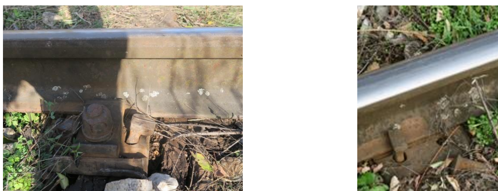
Слика 4.2.5.4: Веза шина праг причврсном плочом и директно причвршћење колсечним ексерима
