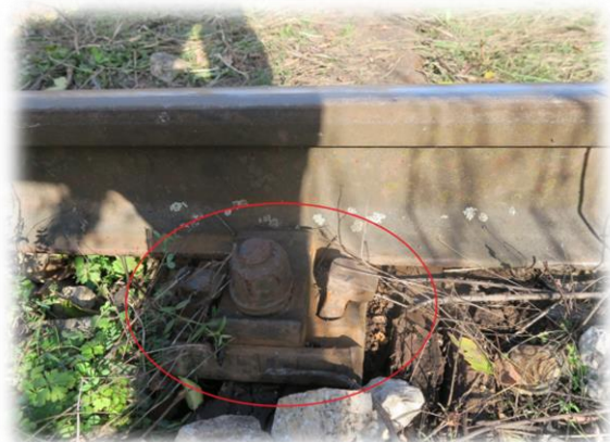
Слика 4.2.3.2: причвршћење ексерима
