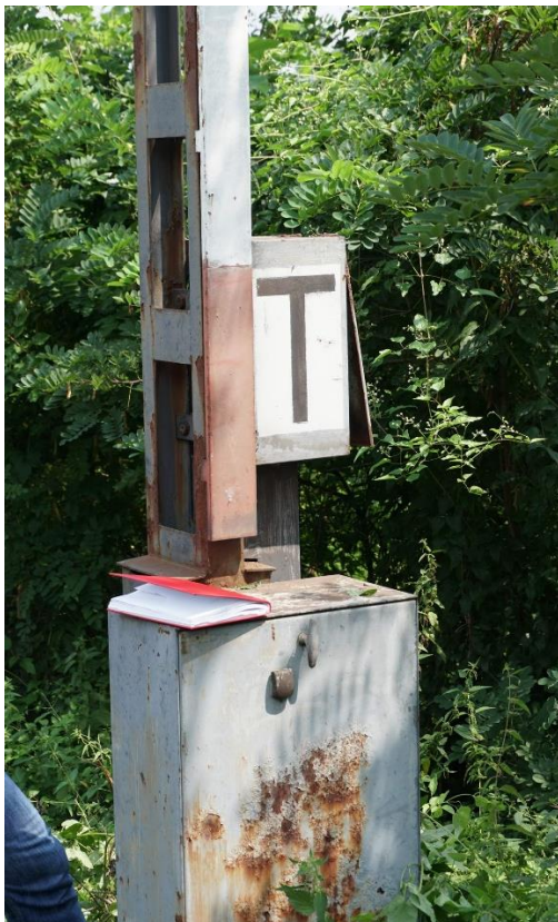
Слика 3.4.3.1: Спољашњи и унутрашњи изглед ТТ ормарића на стубу просторног сигнала E 51
