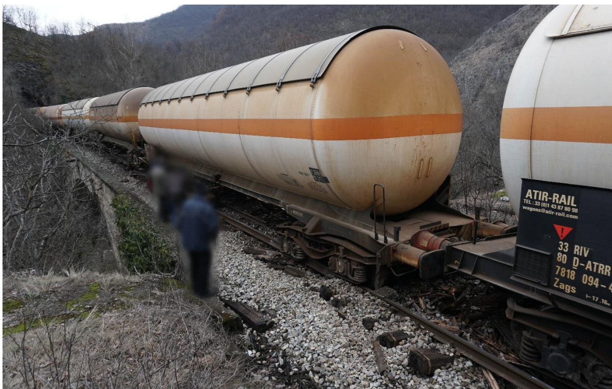
Слика 3.1.1: Изглед места исклизнућа (бетонски мост између тунела број 21 и тунела број 22)
