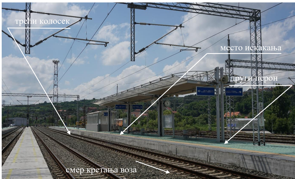
Слика 3.2.1: Изглед места искакања (поглед из смера станичне зграде - првог станичног колосека)
