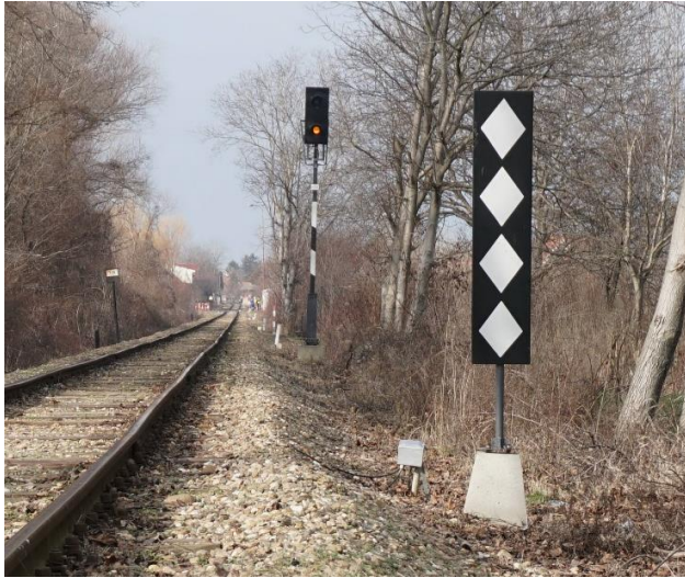
Слика 2.2.3.14: Изглед сигнала на индустријском колосеку (поглед из смера Рафинерије нафте Панчево)
