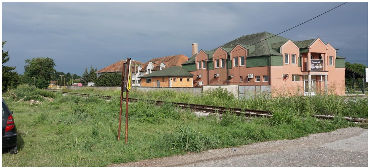
Слика 2.2.3.18: Изглед комплекса (поглед из смера насеља Змињак)
