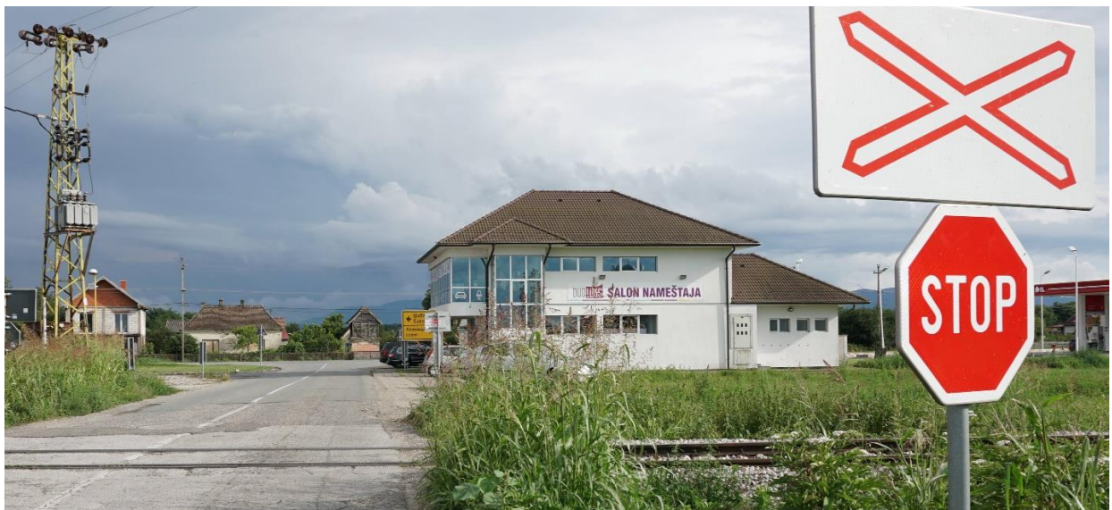
Слика 2.2.3.20: Изглед објекта (поглед из смера насеља Змињак)
