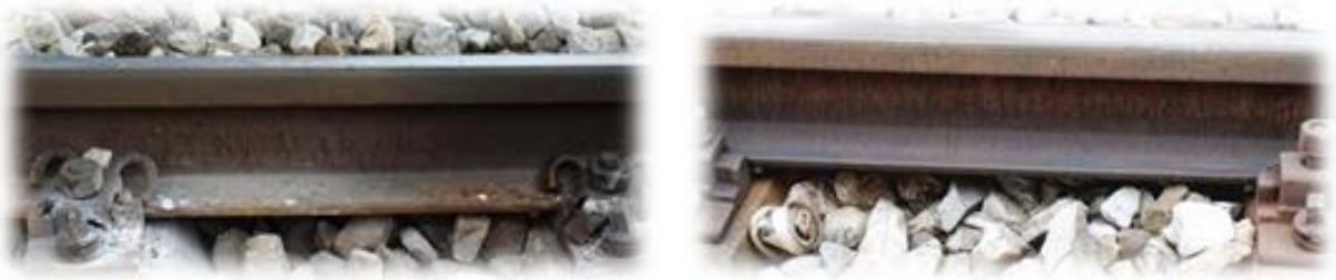
Слика 3.4.2.1: Изглед шина типа „49E1“ ZENICA 86 UIC 49
