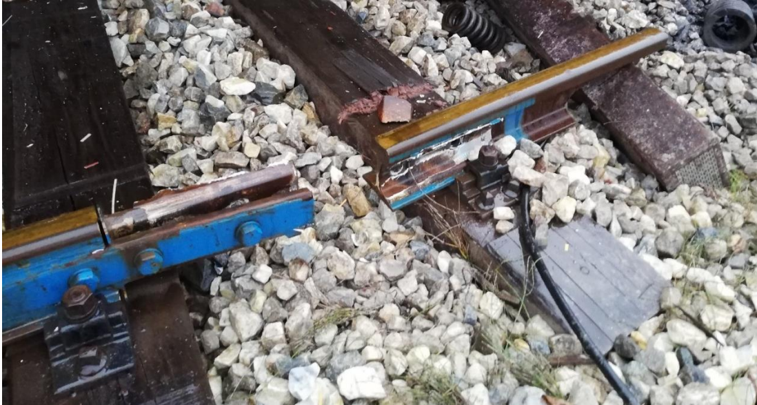
а) Изглед изолованог састава на левој шини у смеру растуће стационаже
