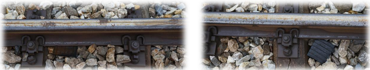
Слика 3.4.2.7: Изглед подужног померања шина
