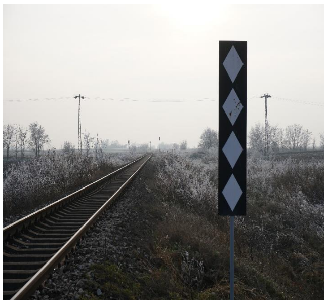
Слика 2.2.3.15: Изглед сигнала укључне тачке на магистралној прузи (поглед из смера станице Бајмок)
