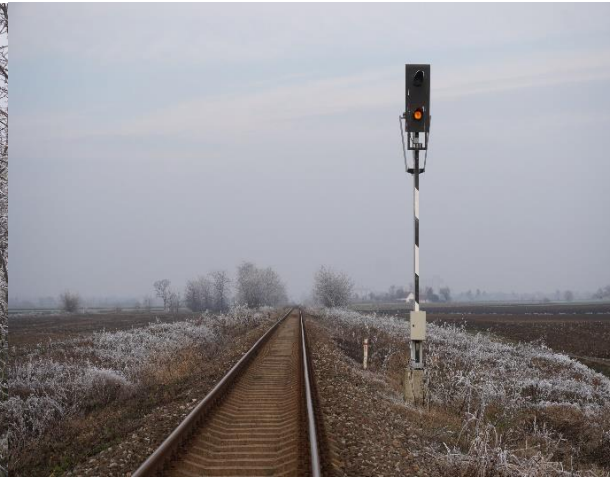
Слика 2.2.3.18: Изглед контролног сигнала KS 1 (поглед из смера станице Алекса Шантић)
