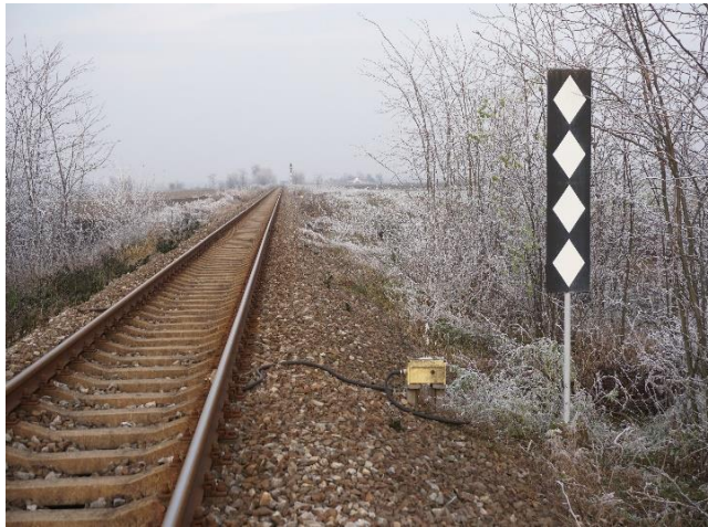
Слика 2.2.3.17: Изглед сигнала укључне тачке на магистралној прузи (поглед из смера станице Алекса Шантић)
